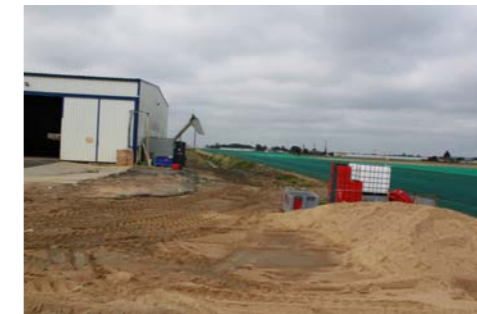
• Le fossé intérieur non perceptible
